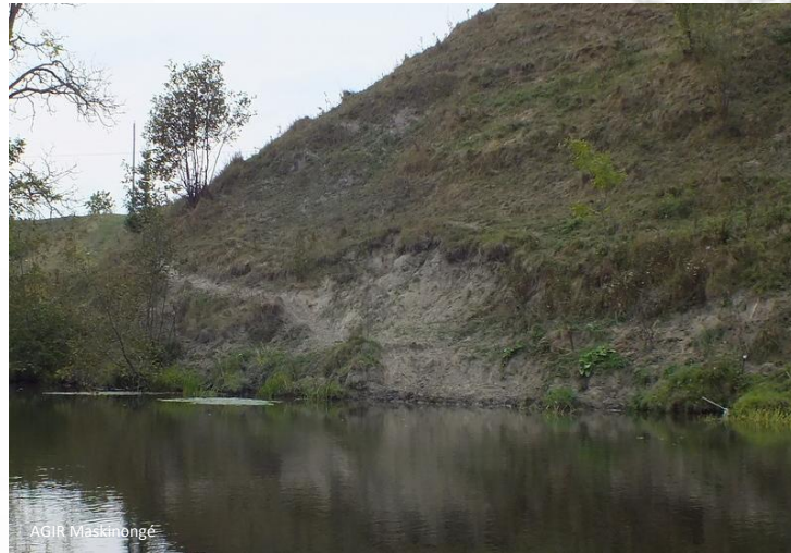
Figure 3.5. 12 : Rive piétinée par le bétail le long de la rivière Maskinongé. Une clôture électrique est présente, à moins d'un mètre du bord de l'eau.
