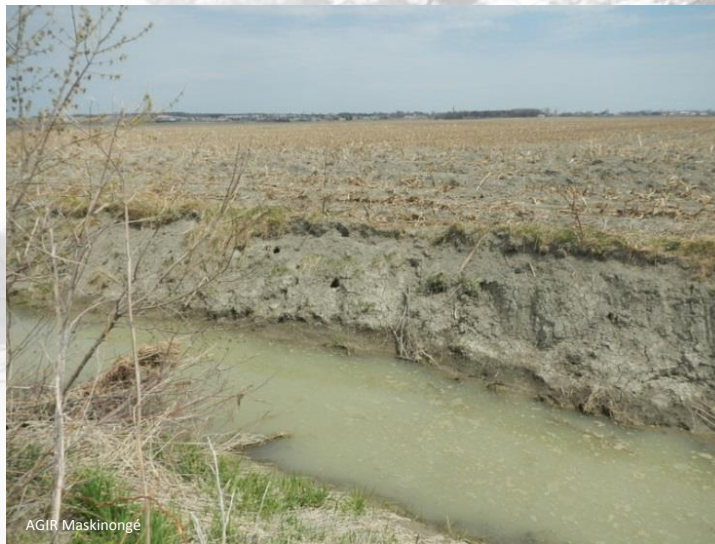
Figure 3.6.15 : Rive dégradée de l'Ormière
