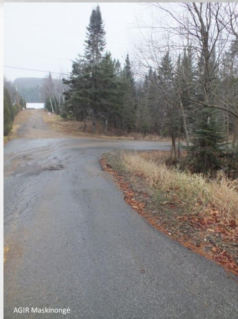
Figure 3.5.5 : Chemin en pente donnant directement sur le lac Long
