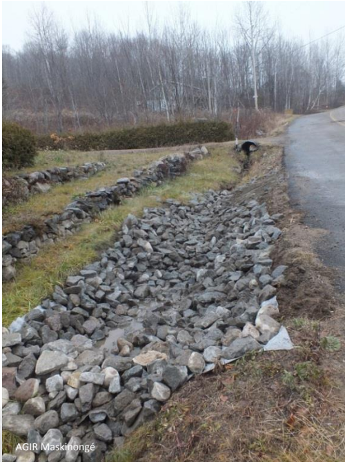
Figure 3.5.4 : Seuil aménagé dans un fossé au lac Long
