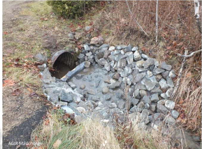
Figure 3.5.3 : Seuil en amont d'un ponceau dans un fossé au lac Long
