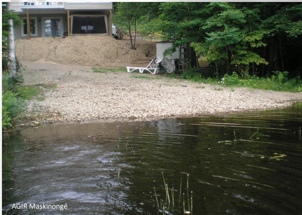
Figure 3.5. 2 : Construction récente avec remblais sur la rive au lac Thomas
