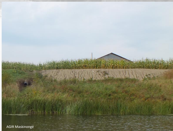
Figure 3.5. 11 : Érosion provoquée par les cultures le long de la rivière Maskinongé
