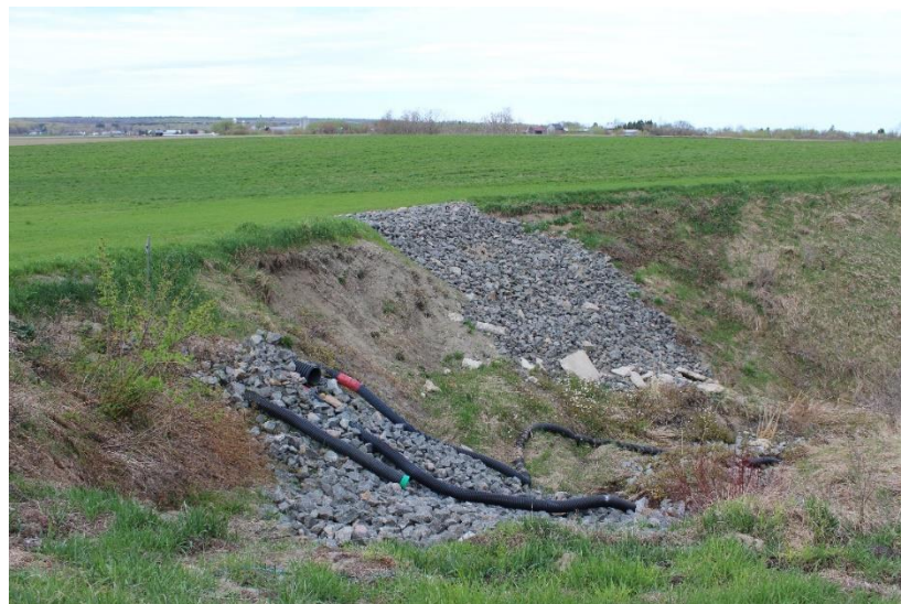
Figure 5. Aménagement d'une descente enrochée avec risbermes et stabilisation de sorties de drainage à Saint-Justin
