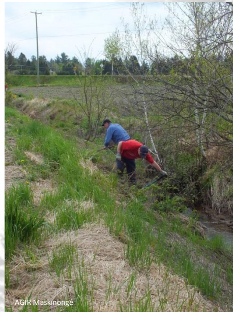
Figure 3.3.20 : Plantation de Sorbaria pour stabiliser le talus du ruisseau Lafrenière
